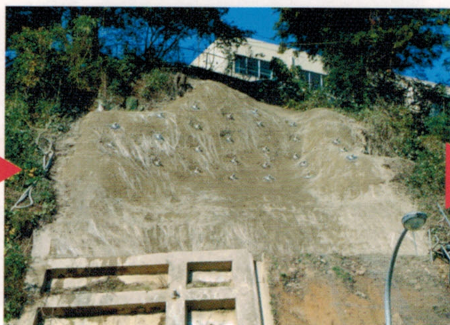
かんじきくん施工後 (連続繊維補強土工との組合せ)
