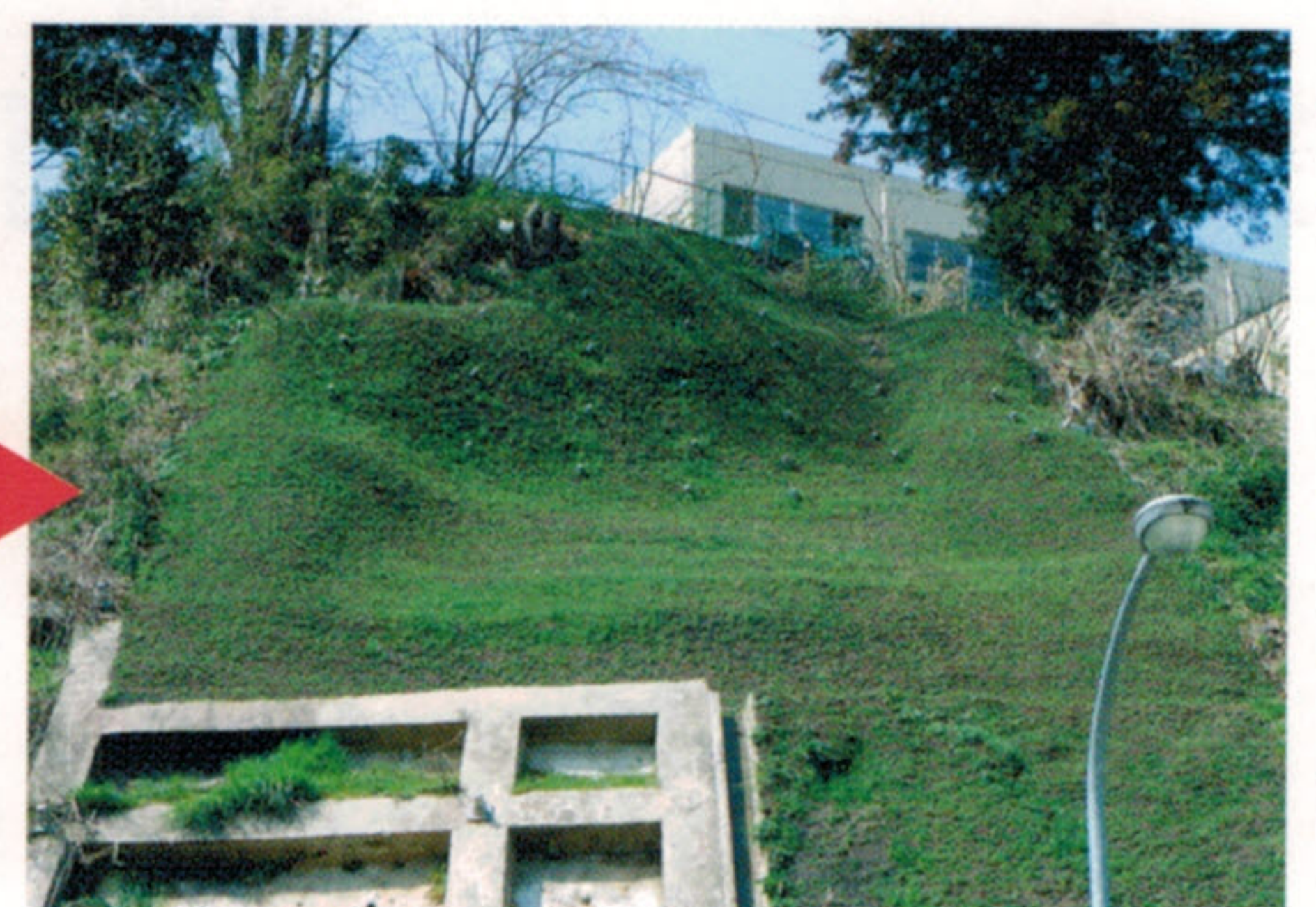
緑化工施工後
