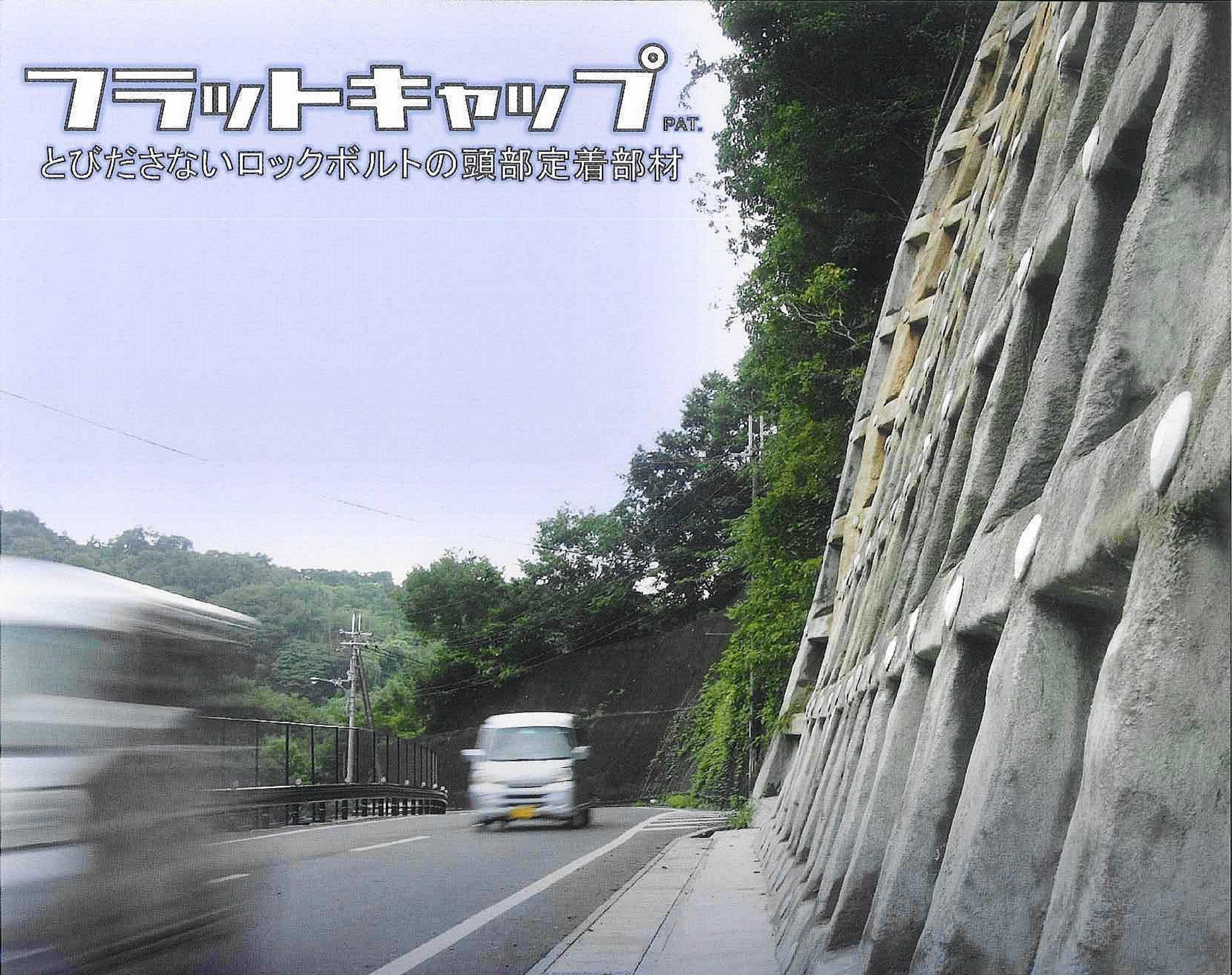
鉄筋挿入工の表面材において、施工期間の短縮がはかれるプレキャスト受圧板の利用が増えています。それらは素材と構造に工夫をこらし、強度や耐久性を確保しながらも製品は薄く、景観に配慮したものとなっています。
